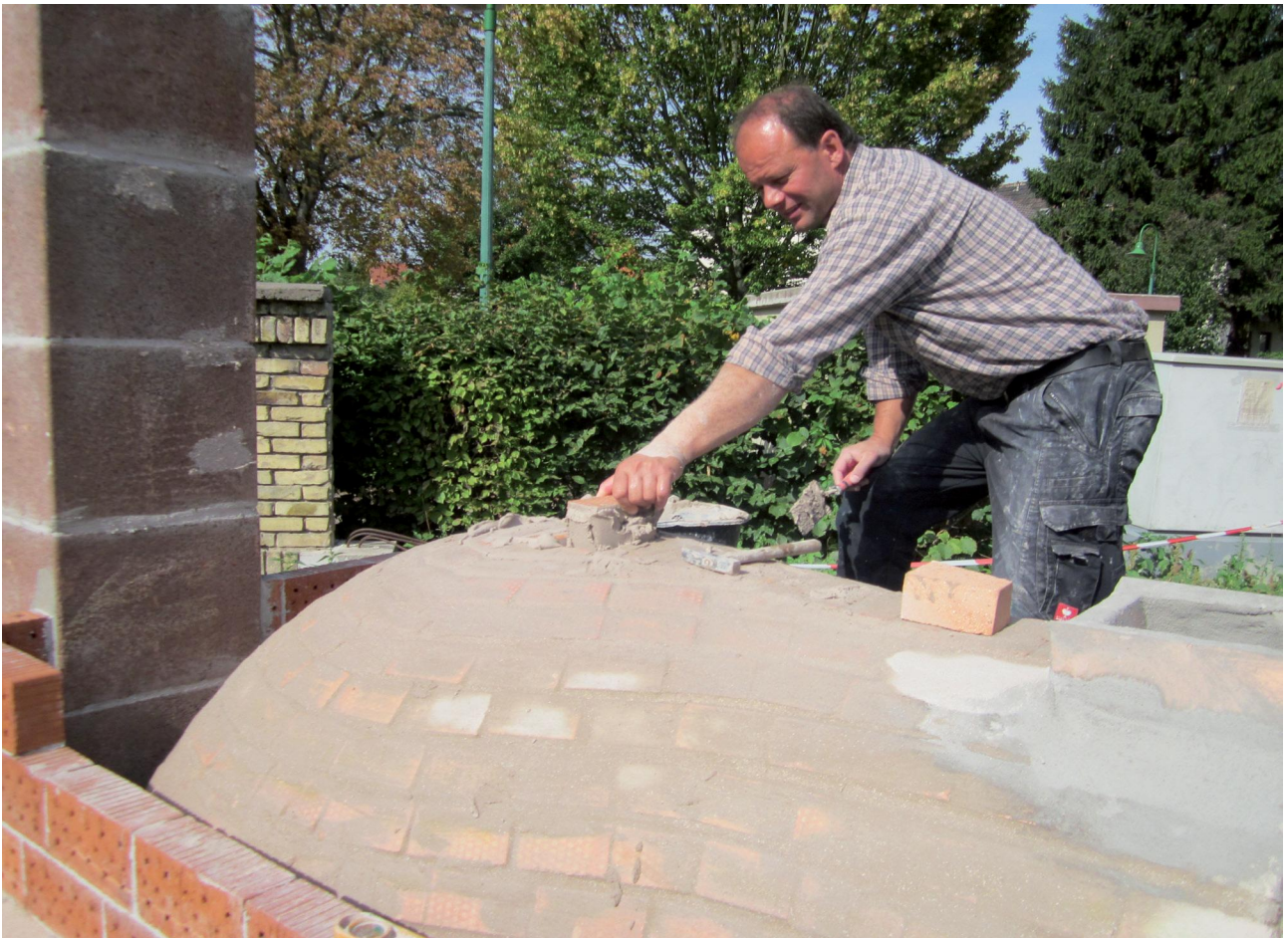
Der finale Stein des Gewölbes wird gesetzt
